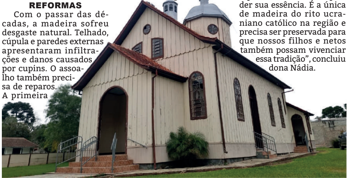
A igreja, com mais de 70 anos, conta com a mesma estrutura desde quando construída
