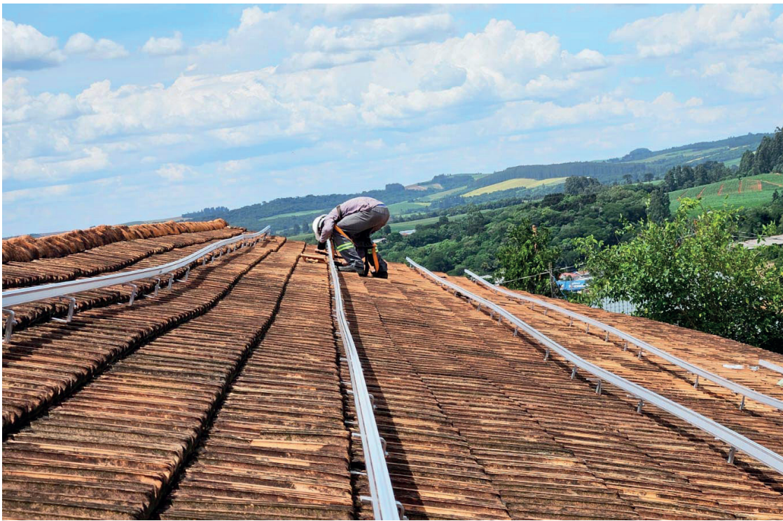
Atualmente está sendo feita a instalação da base estrutural de ferro para dar suporte às placas
